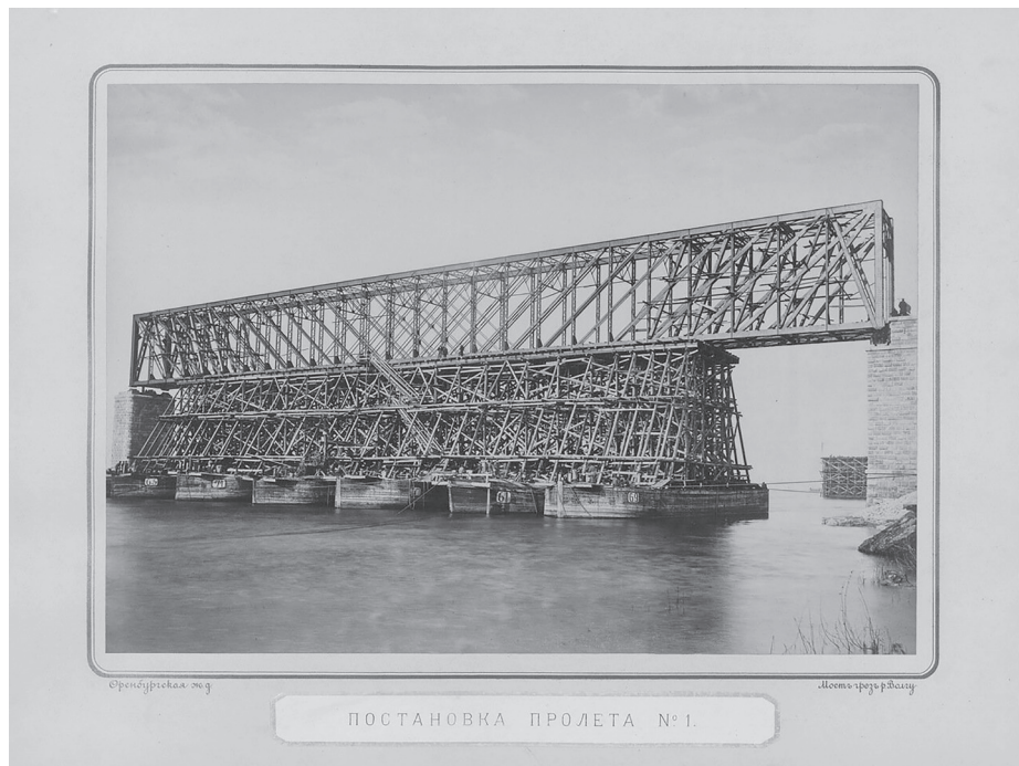
Постановка пролета № 1. Мост через Волгу.
